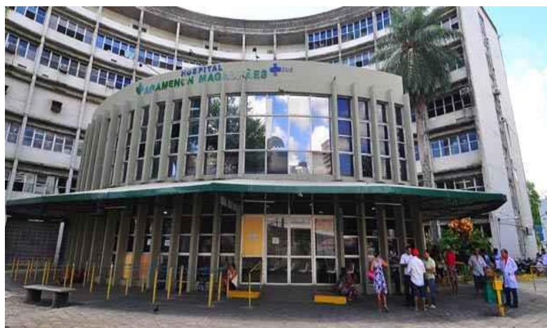
Figura 1 Fachada Hospital Agamenon Magalhães
