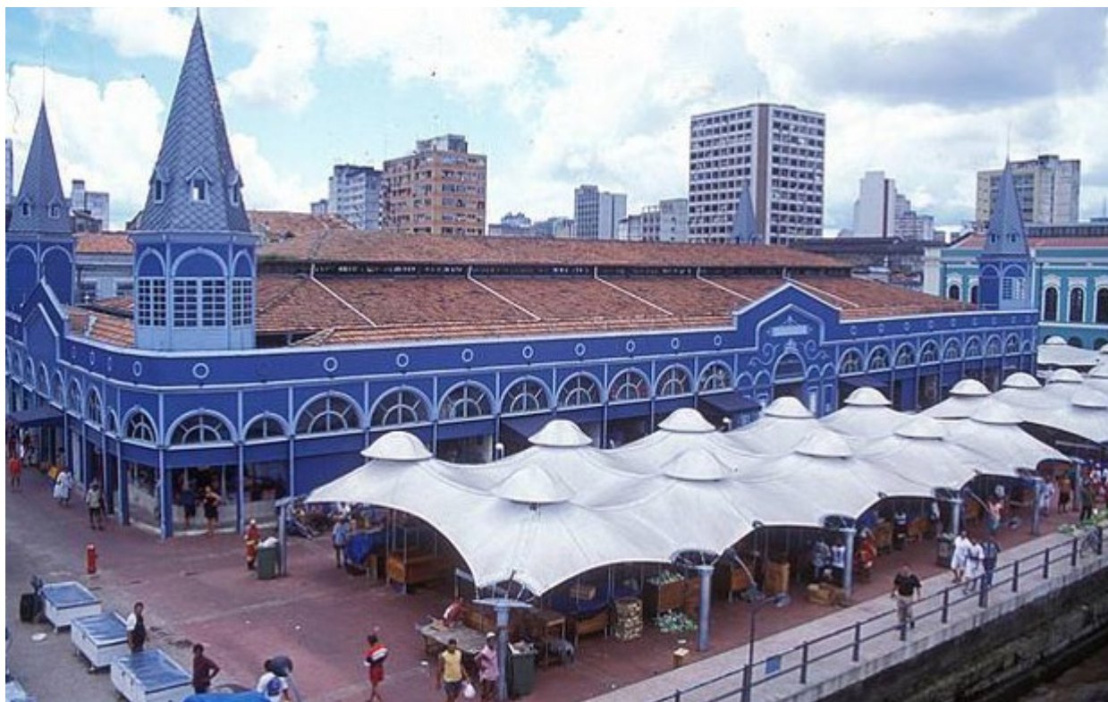
Figura 1 – Vista parcial do Complexo do Ver-o-Peso
